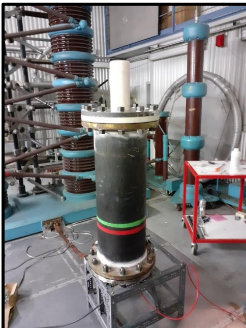
500kV 20ns Marx generator
