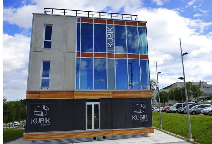
Kubik de Tecnalia (Bilbao)
