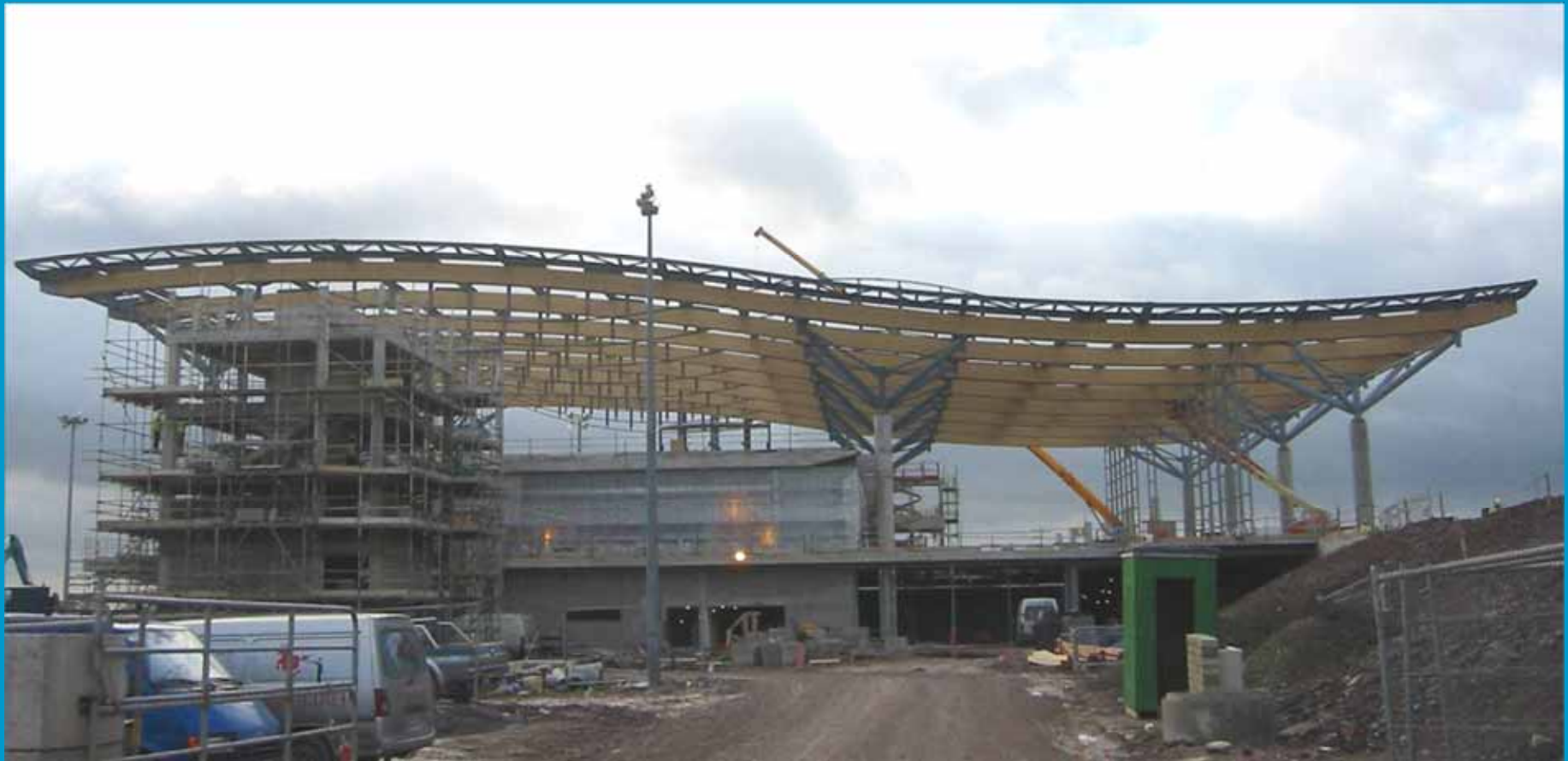
Aeroporto di CORK Airport in Irlanda (84,50 X 178,00 m)
